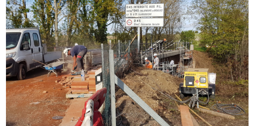
Le pont en chantier
