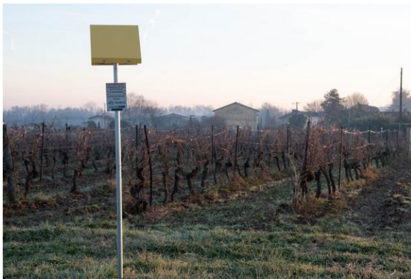
Borne permettant de repérer la canalisation existante
